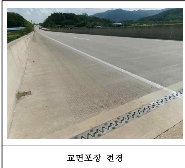
【사진 7.3.19】 교면포장 전경
