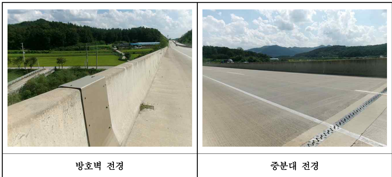
【사진 7.3.23】 방호벽 및 중앙분리대 전경
