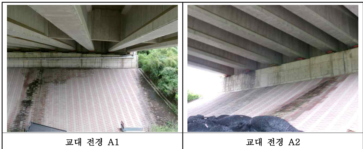
【사진 7.3.33】 교대 전경
