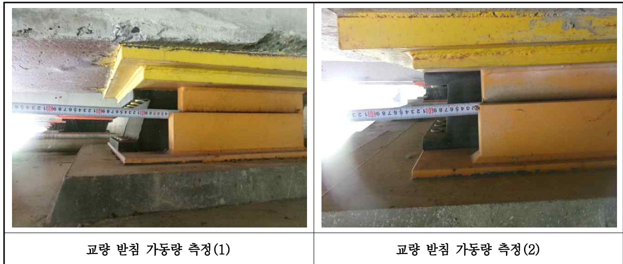
【사진 7.3.15】교량받침 이동량 측정
