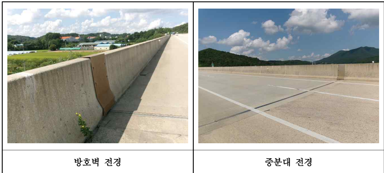
【사진 7.3.48】 방호벽 및 중앙분리대 전경
