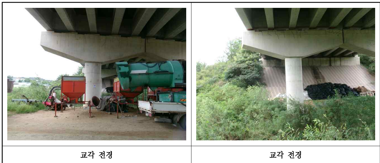
【사진 7.3.35】 교각 전경
