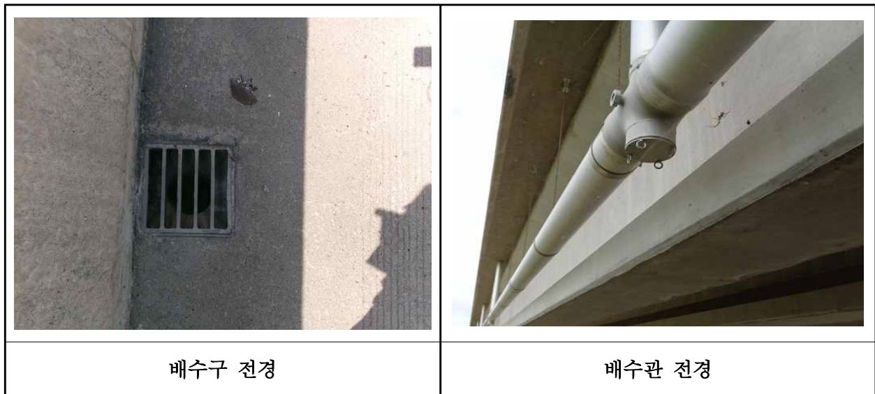
【사진 7.3.46】 배수시설 전경
