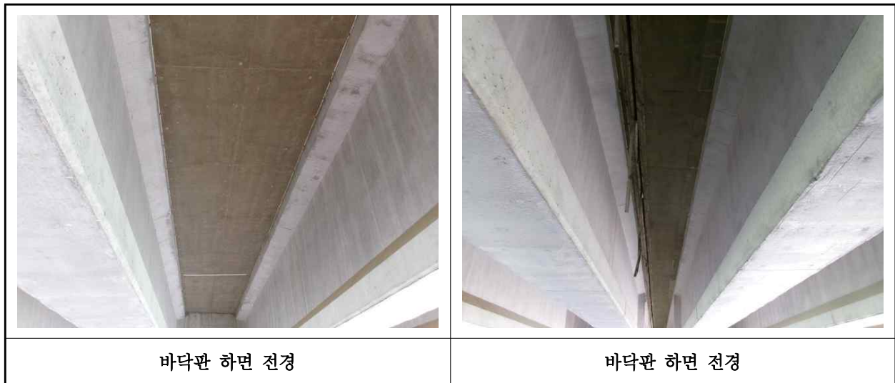
【사진 7.3.27】 바닥판하면 전경
