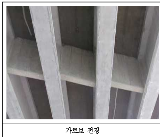
【사진 7.3.31】 가로보 전경
