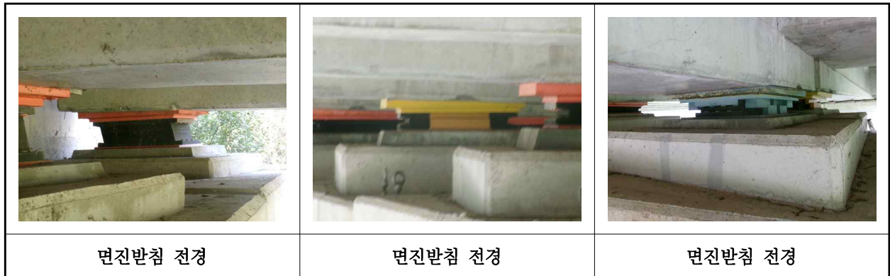
【사진 7.3.12】 교량받침 전경
