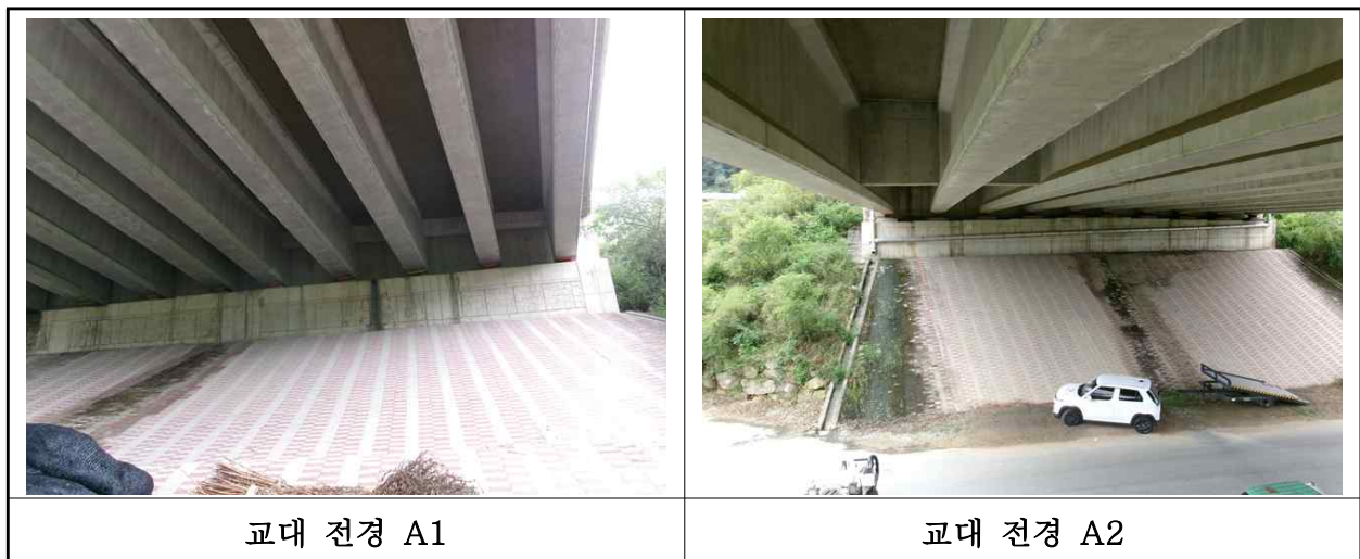
【사진 7.3.8】 교대 전경
