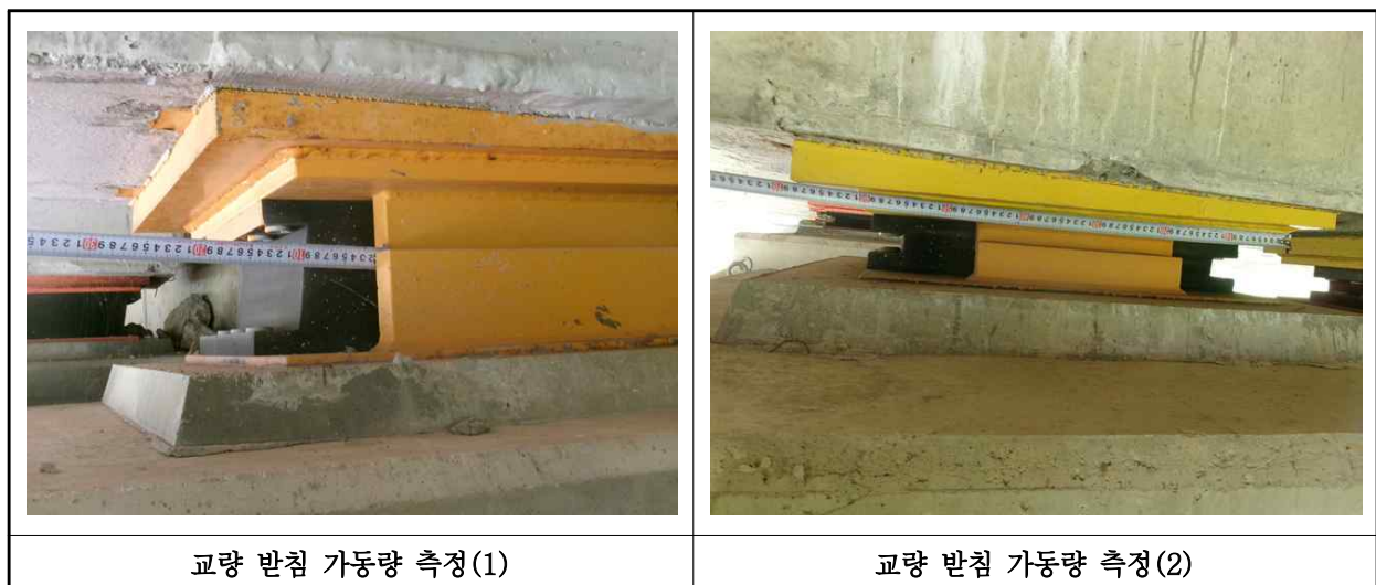
【사진 7.3.40】교량받침 이동량 측정
