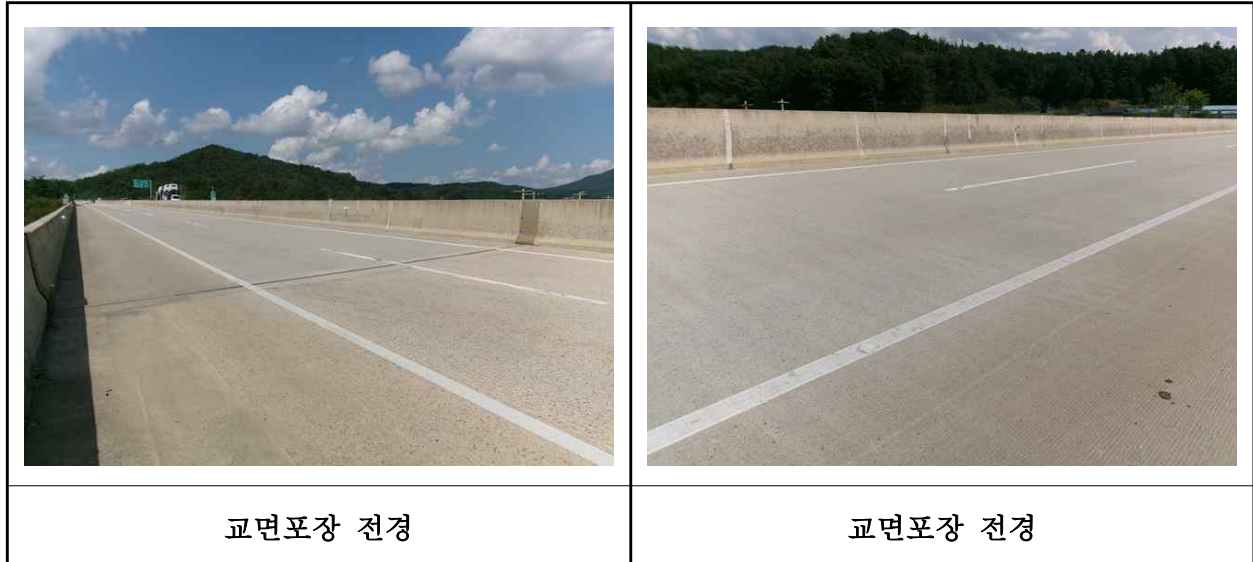
【사진 7.3.44】 교면포장 전경
