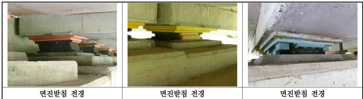
【사진 7.3.37】 교량받침 전경
