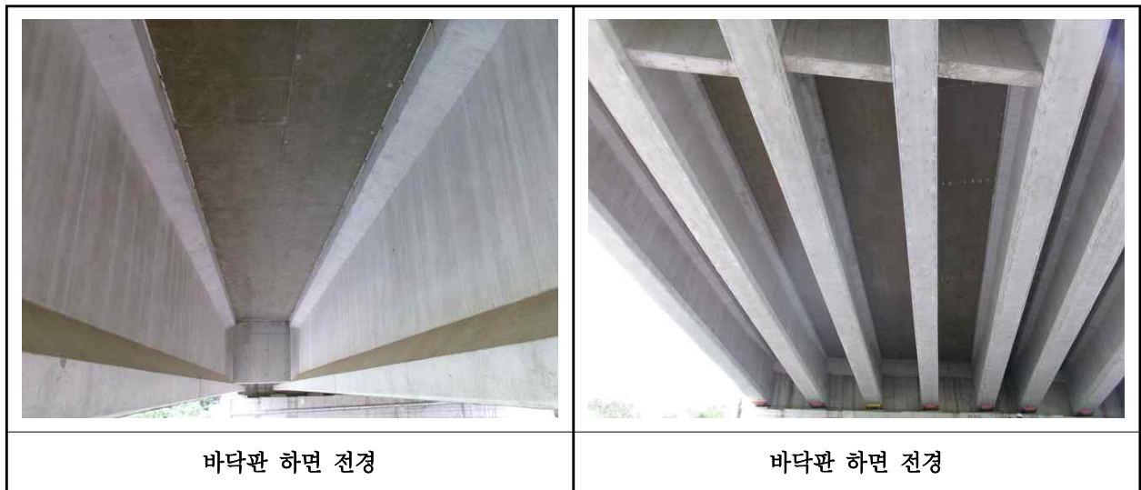
【사진 7.3.2】 바닥판하면 전경
